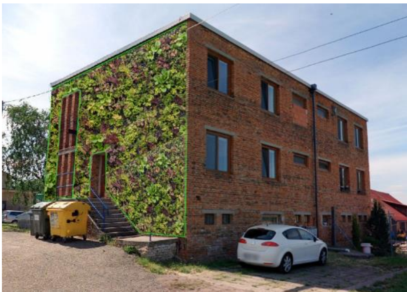
Obrázek 10: Navržené řešení zelené fasády na jižní straně
